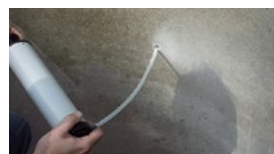
2. Vyčistíte vyvrtanú dieru
