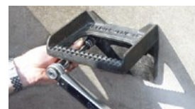
6. Kotvu osadíte a momentovým kľúčom utiahnete na požadovaný moment T_{inst} = 25\text{Nm}
