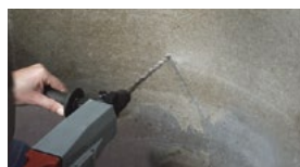
Jednoduchá montáž, rýchle a bezpečné kotvenie 1. Vyvrtajte otvor.
